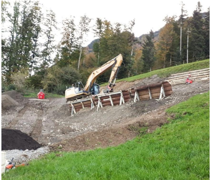
**Einbau der Faschinen zur Sicherung des Hangs**
